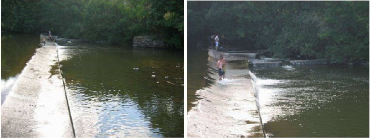
Figure 210 : Barrage de Lempdes et passe à poissons le 29 juillet 2009 (Débit de 1 m 3 /s). (Source : LOGRAMI)
