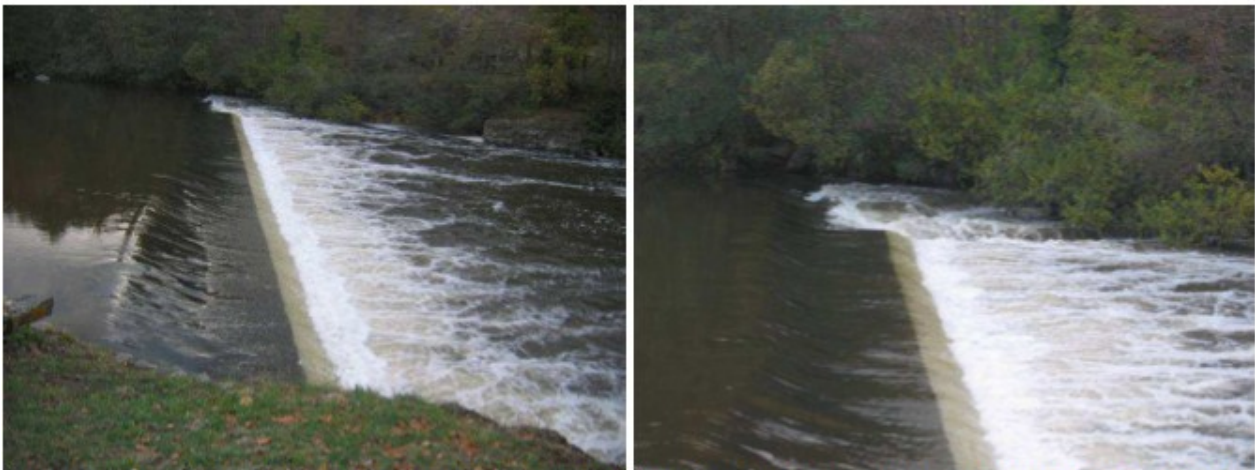
Figure 211 : Barrage de Lempdes et passe à poissons le 5 novembre 2009 (Débit de 21 m 3 /s). (Sources LOGRAMI)
