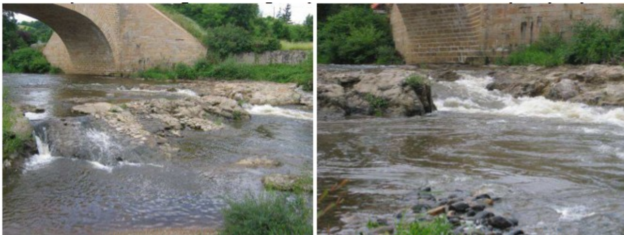
Figure 208 : Seuil de Grand Pont le 10 juin 2009 (débit de 7,7 m 3 /s) (Source : LOGRAMI)
