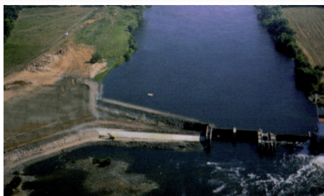
Barrage de Maisons-Rouges avant démantèlement
