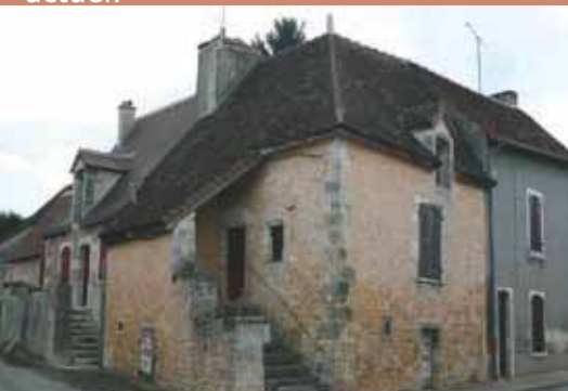
Bâti traditionnel à Fontgombault
